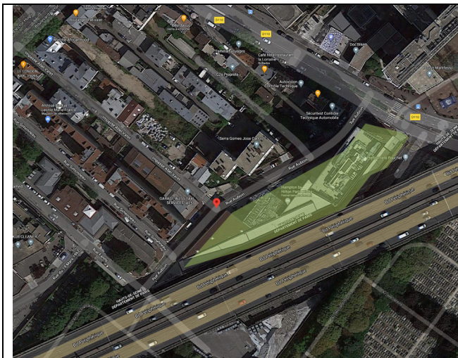
Nouvel immeuble rue Auboin 92110 Clichy en 2020 (vue aérienne)
